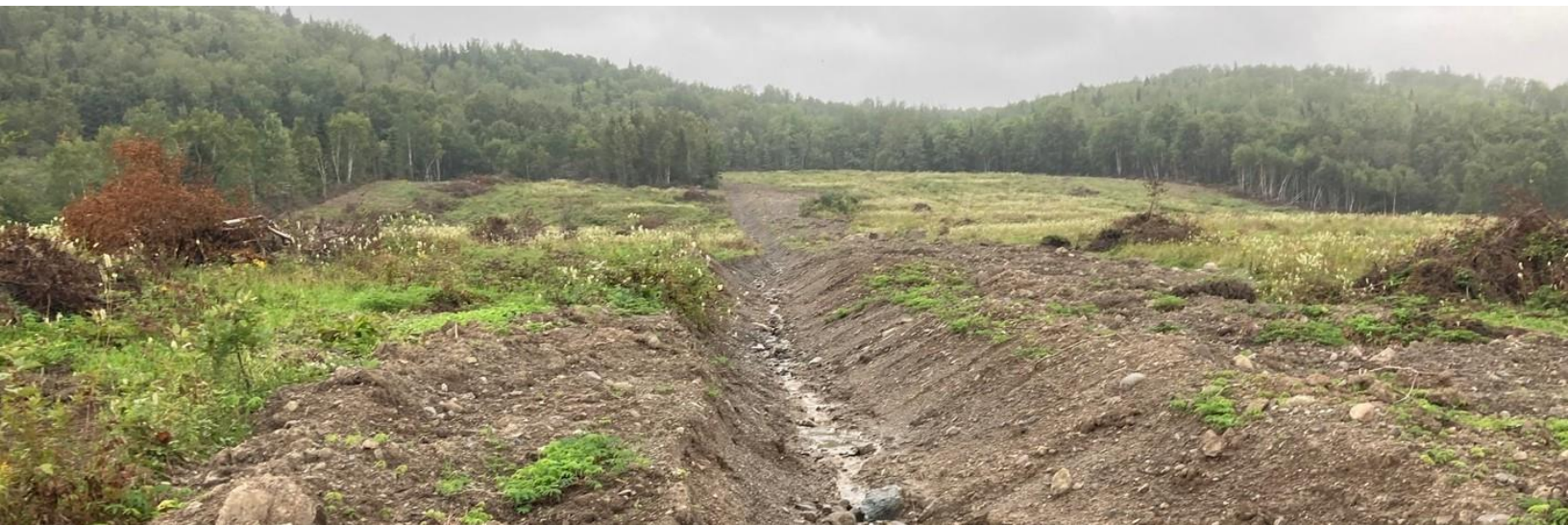
Le creusage d'un fossé d'écoulement des eaux pour un projet de remise en culture à Saint-Louis-du-Ha! Ha! MRC de Témiscouata
